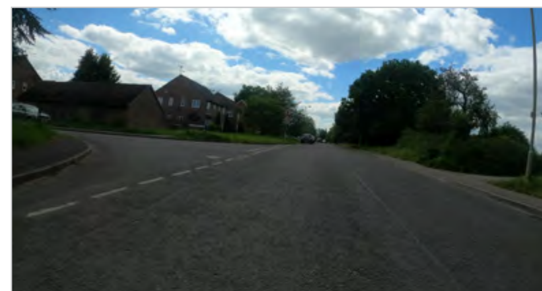
200.1.2 – London Road Holybourne
